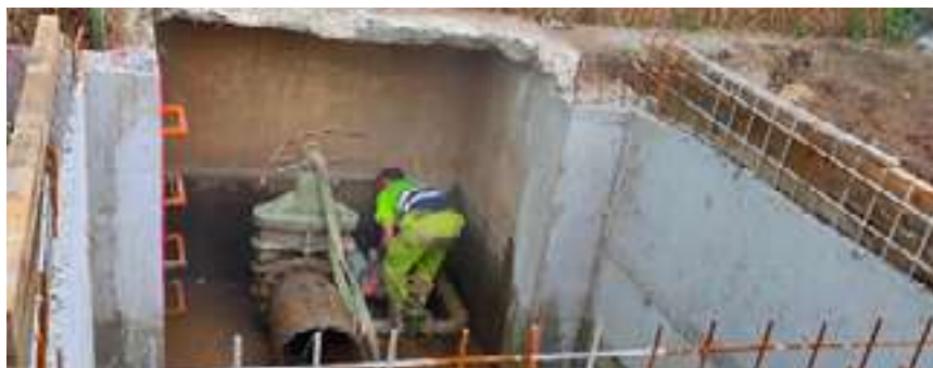
Tubería del Golako (Lorategieta)
