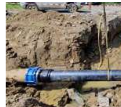
Tubería del Golako (Arratzu)
