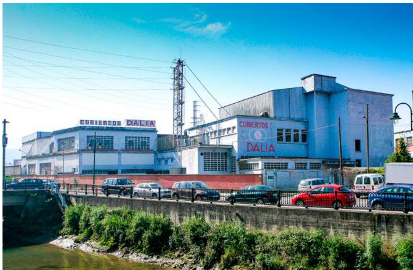
Antiguas instalaciones de la Fábrica de cubiertos de Dalia, Gernika-Lumo
