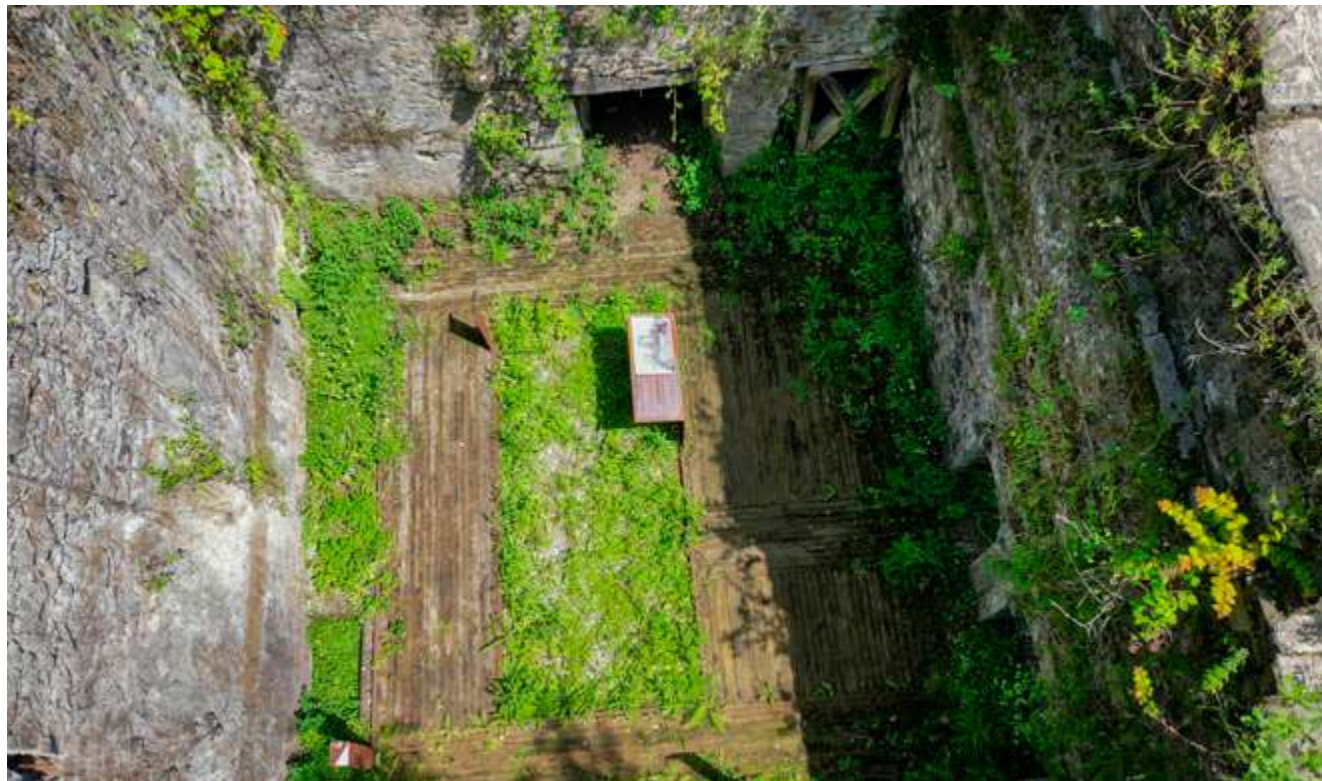
Vista del interior de la antigua zona de trabajo de la ferrería
