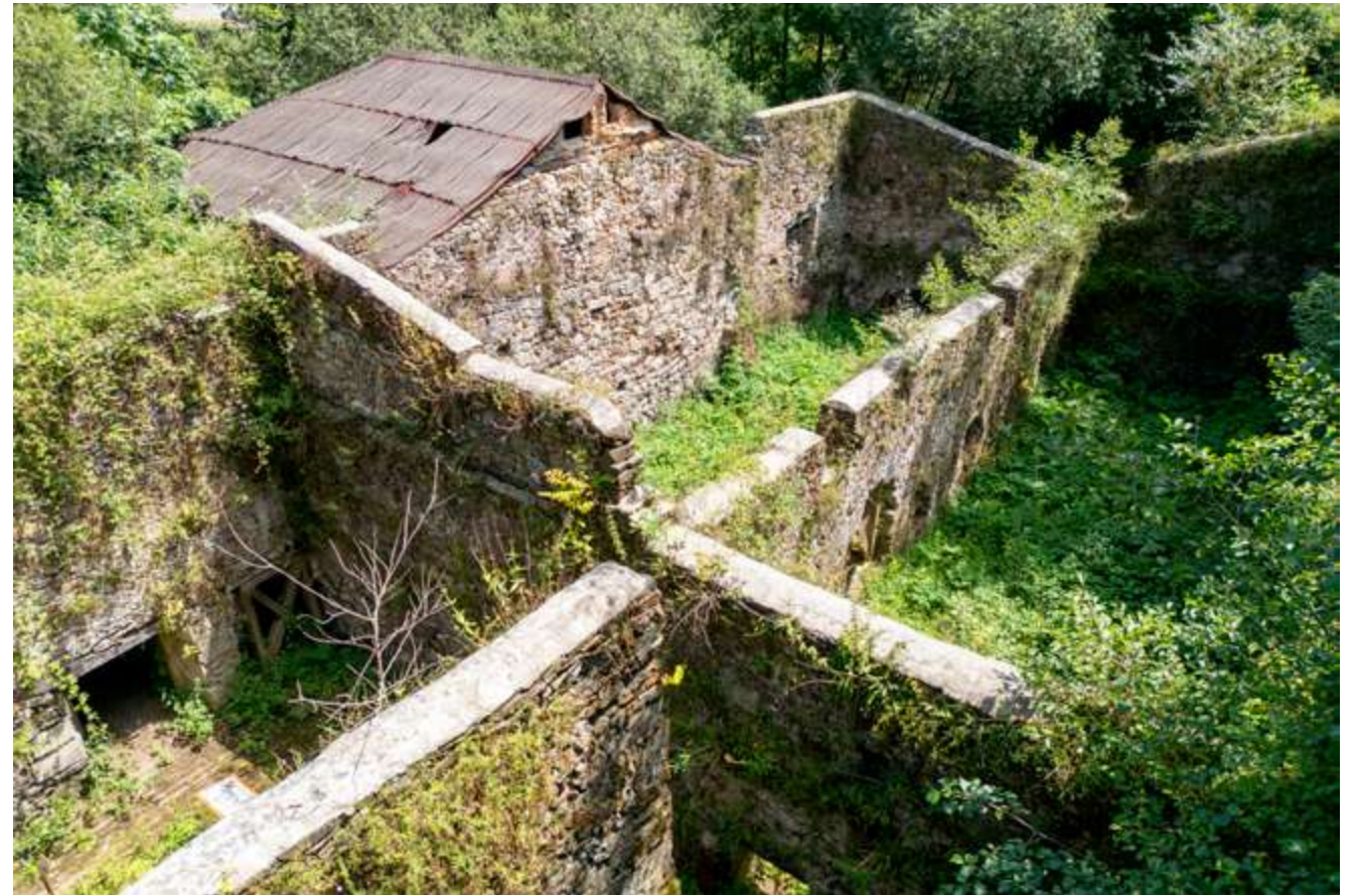
Muros en la zona de las carboneras
